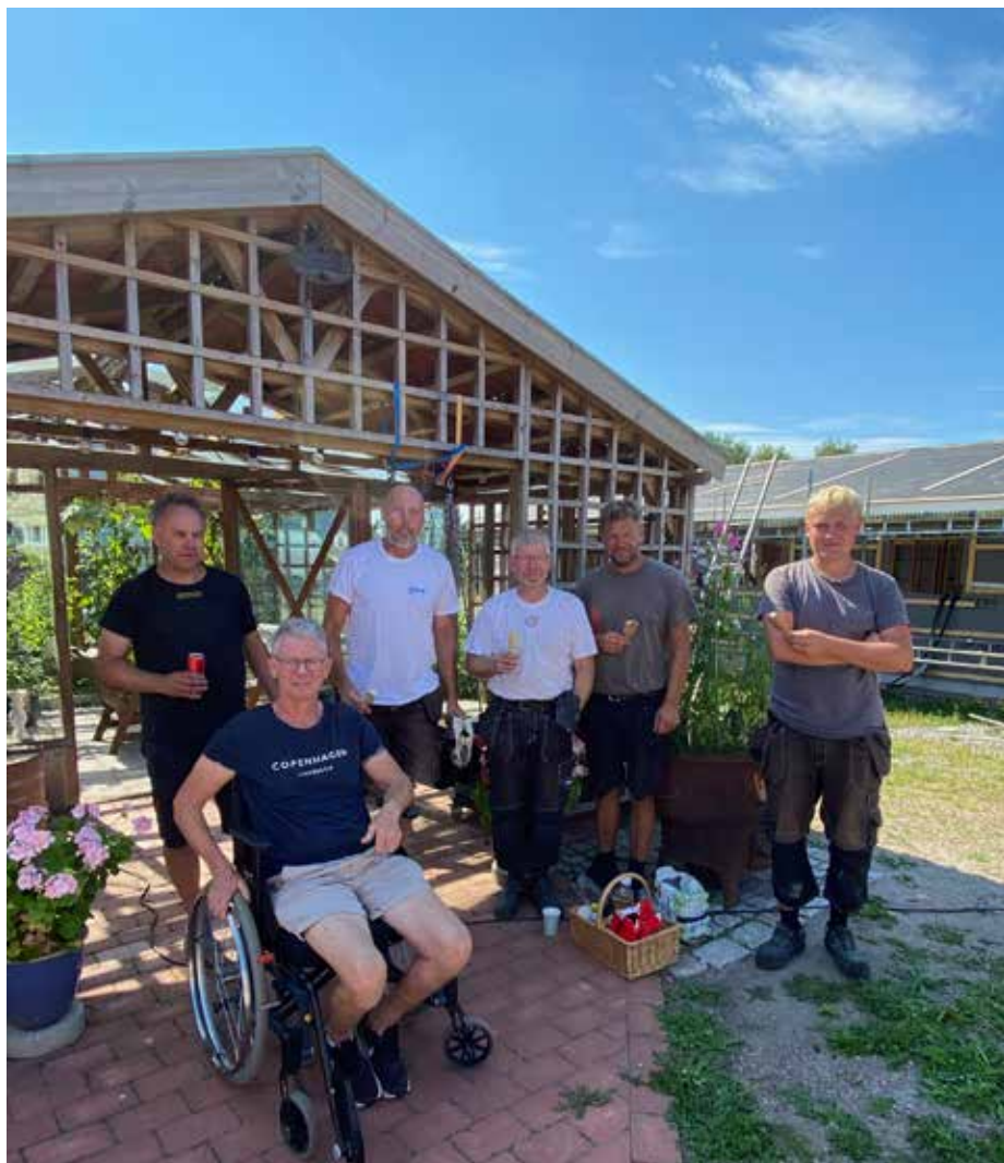
Arbetskamrater, grannar och vänner hjälpte Dan Bengtsson i somras efter olyckan på byggställningen hemma i Nyby.
